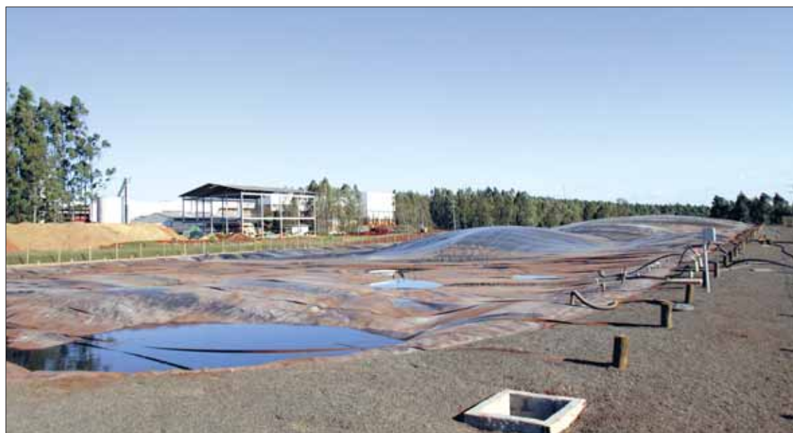
Biodigestores localizados na Unidade Industrial de Aves da Cooperativa Lar
